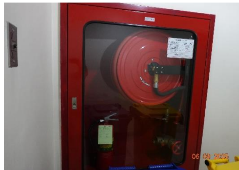
ตู้สายฉีดน้ำพร้อมอุปกรณ์
