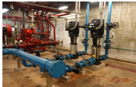
พื้นที่ถังเก็บน้ำใต้ดิน พร้อมเครื่องปั้มน้ำ
